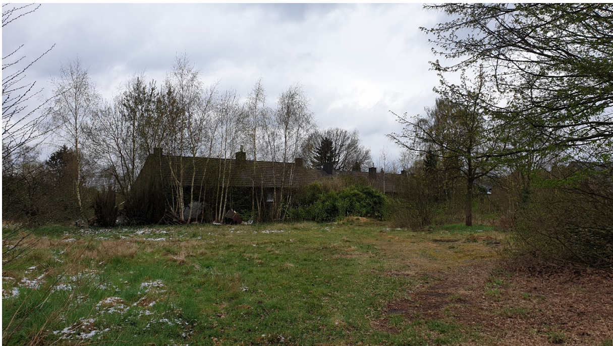
Abbildung 5b: Ältere Gebäude im UG, welche abgerissen werden müssen
