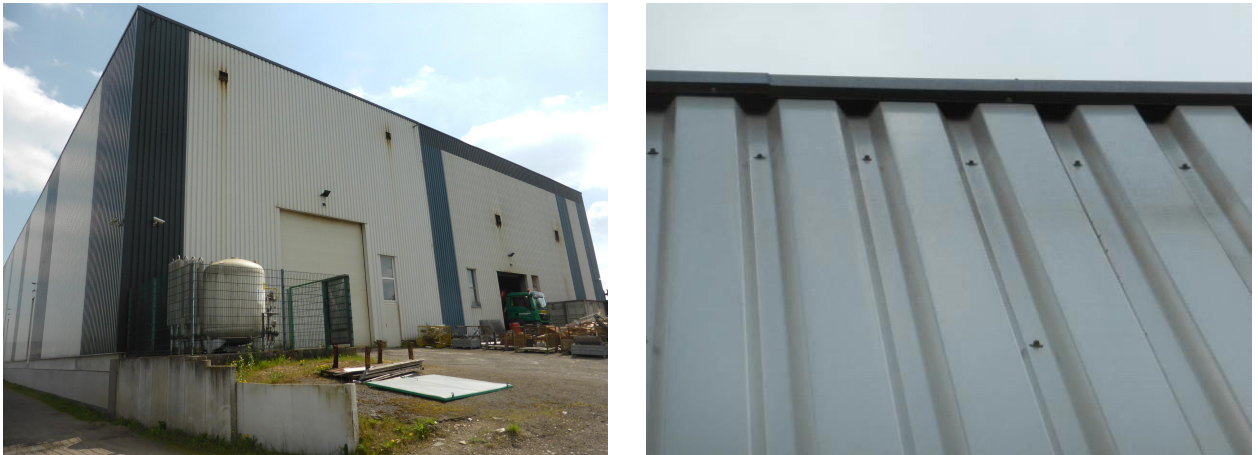
Abbildung 3: li: Gewerbehalle; re: Detail Gebäudehülle (alle Spalten verschlossen)
