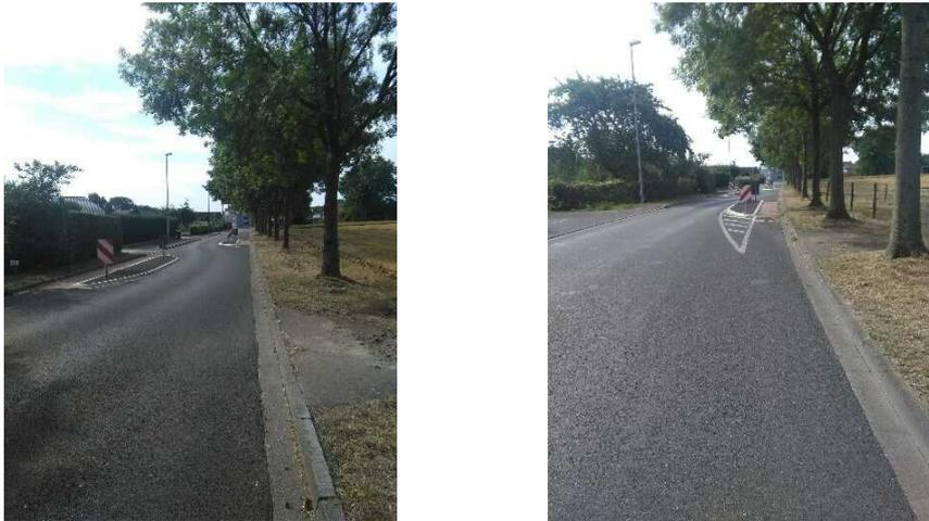
**Bild 58:** Beispielhafte bauliche Fahrbahnverschwenkung mit Durchfahrtsmöglichkeit für den Radverkehr (Foto: P3 Agentur)
